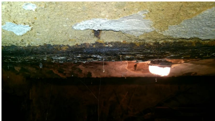
fot. nr 2 korozja ogólna belki stropowej- belka w prawej piwnicy front
