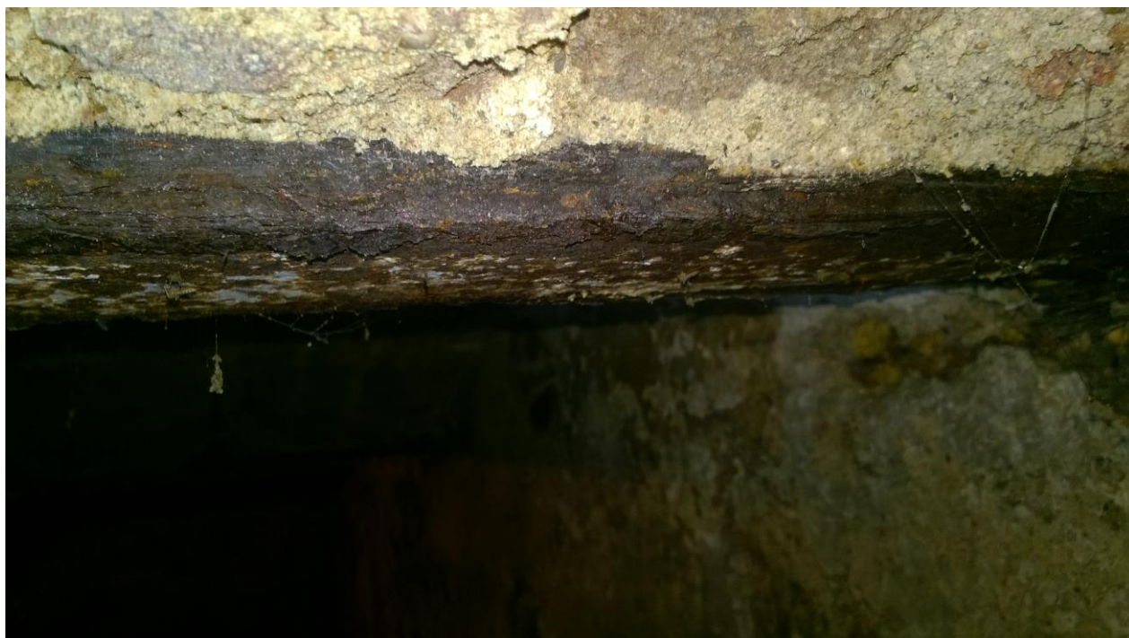
fot. nr 1 korozja powodująca rozwarstwienie dolnych półek belek stropowych -belka skrajnej prawej piwnicy
