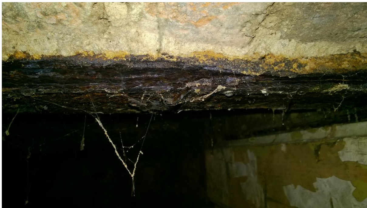
fot. nr 3 skorodowana belka stropowa w skrajnym lewym pomieszczeniu piwnicznym
