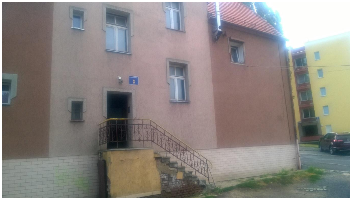
uszkodzone schody żelbetowe zewnętrzne
