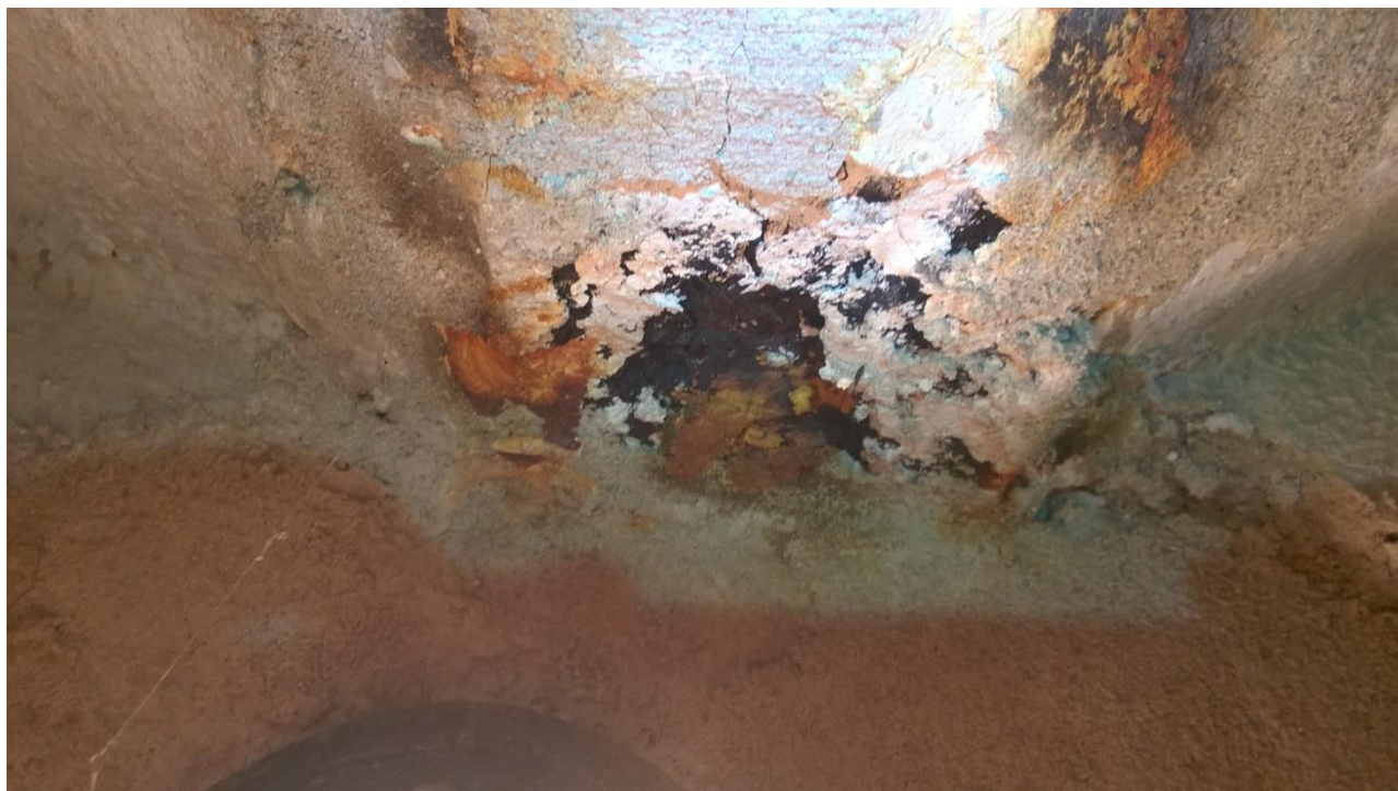
fot. nr 1 rozwarstwiająca korozja dolnej półki belki stropowej w pomieszczeniu piwnicznym nr 1p widoczna zniszczona dolna półka belki w strefie przypodporowej
