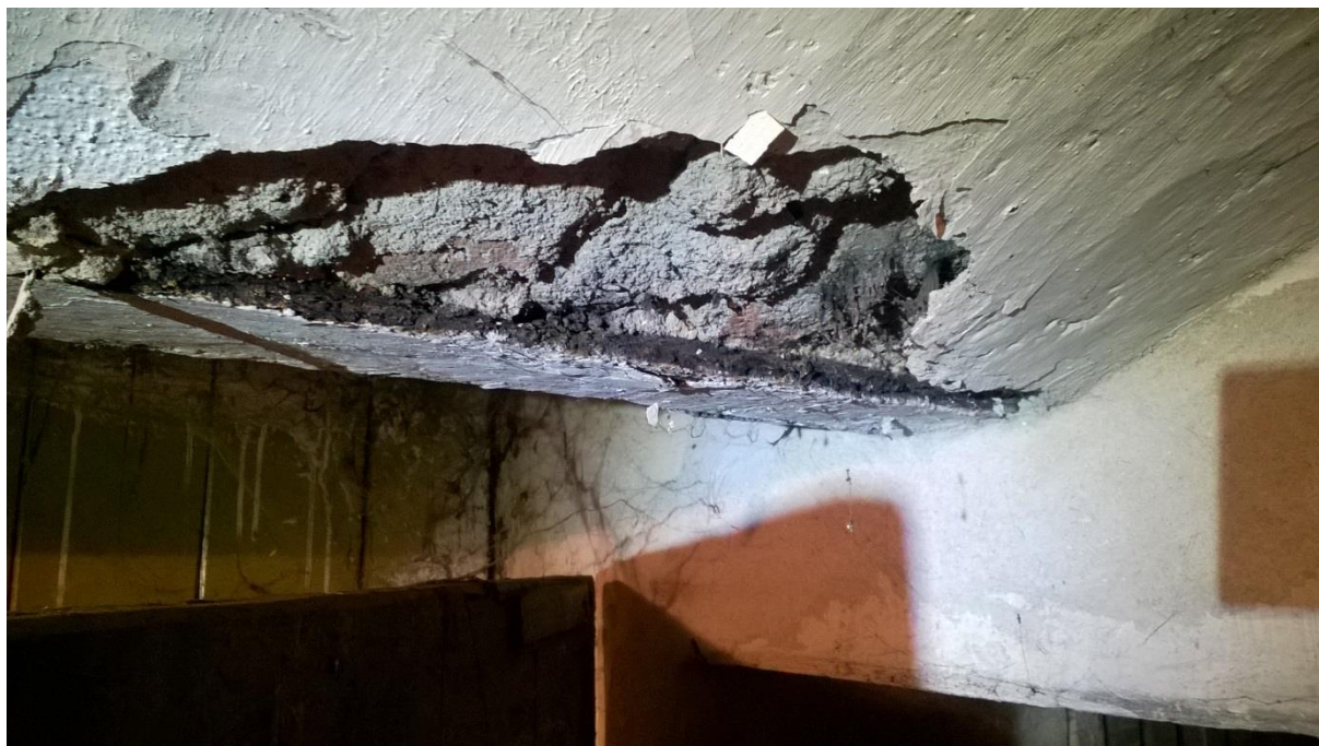
fot. nr 3 widoczne uszkodzenie belki oraz części łukowego stropu pomieszczenie piwniczne nr 3p
